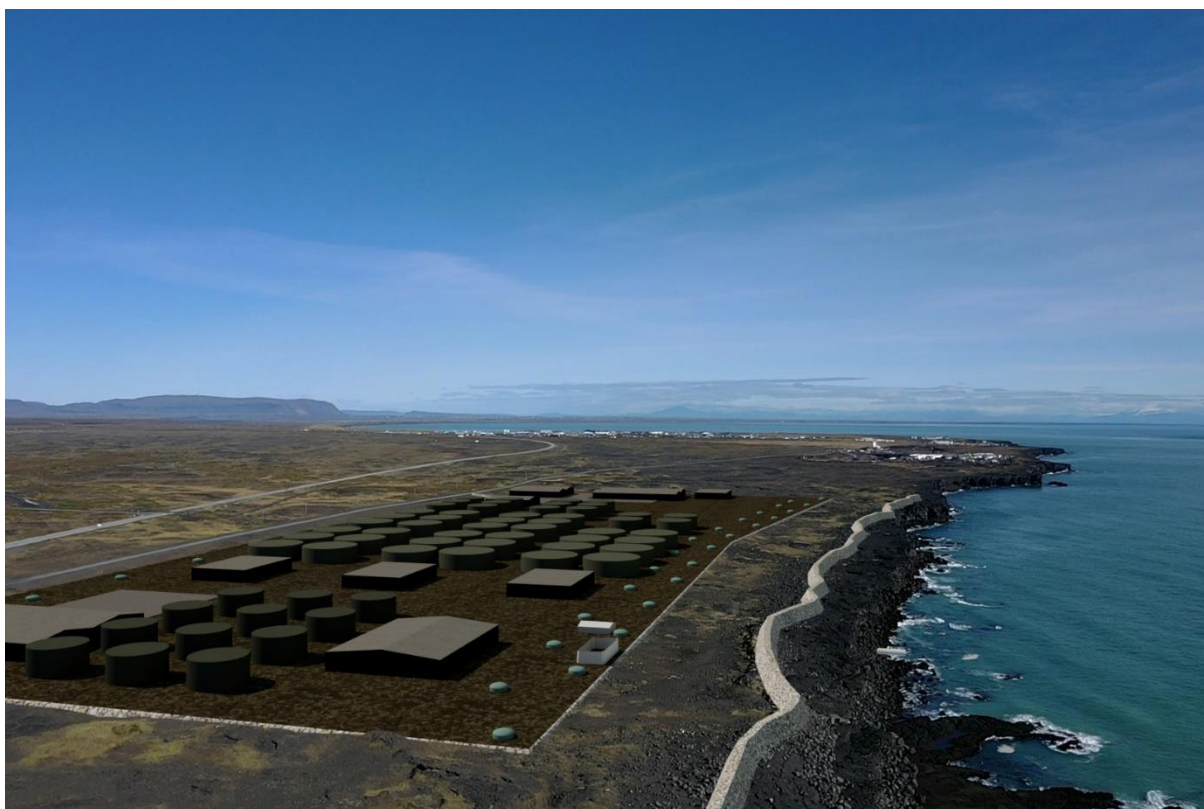
MYND 4.38 Líkanmynd af fyrirhugaðri landeiddisstöð Thors Landeiddis. Myndin er tekin úr lofti og er horft til austurs, yfir lóð framkvæmdaraðila. Líkanmyndir gera ráð fyrir að veggghæð mannvirkja sé um 9 metrar auk 4 metra riss. Stærð lóðar er um 20 ha.
