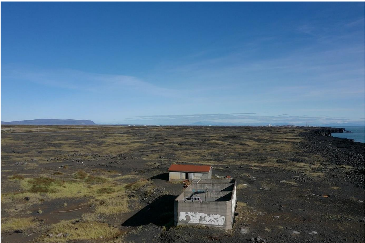
MYND 4.32 Mynd tekin við suðvestur enda lóðarinnar, horft til austurs. Í forgrunni má sjá núverandi byggingar innan lóðarinnar.
